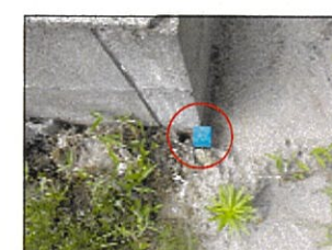
C3242 (既設合成樹脂杭)
