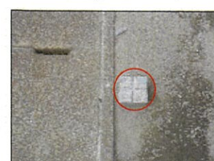
C4101 (既設コンクリート杭)
