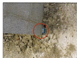
C4133 (既設合成樹脂杭)
