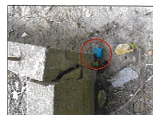
C3246 (既設合成樹脂杭)
