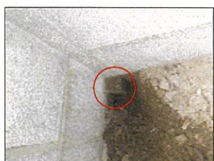
C3243 (既設コンクリート杭)
