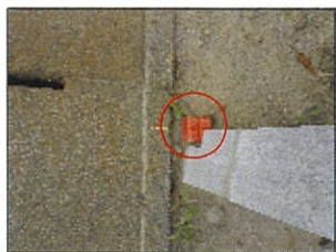
C4096+ (既設合成樹脂杭)
