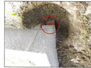
X2 (新設合成樹脂杭)
